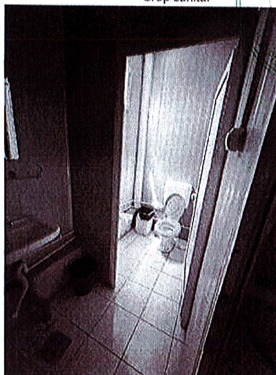
- Grup sanitar closet
