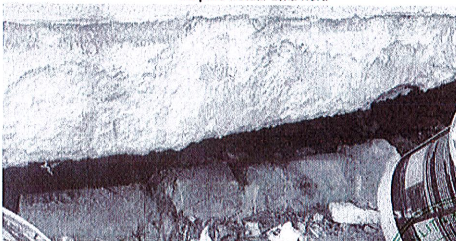
- Surpare trotuar zona Nord
